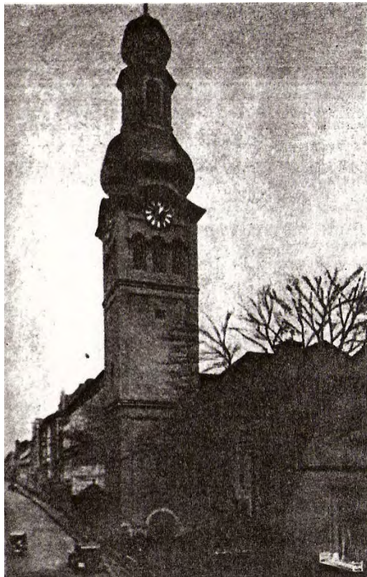
Die Friedenskirche nach der Erneuerung 1935
